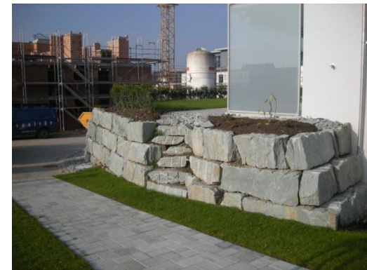
7 MFH Bündli Seengen Neuanlage Andeer-Quader Natursteinmauer mit Treppen / Spez. Andeer Natursteinverbundsteine / Terrassen Natursteinplatten / Bepflanzung / Rasenflächen
