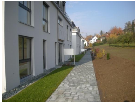
7 MFH Bündli Seengen Neuanlage Andeer-Quader Natursteinmauer mit Treppen / Spez. Andeer Natursteinverbundsteine / Terrassen Natursteinplatten / Bepflanzung / Rasenflächen
