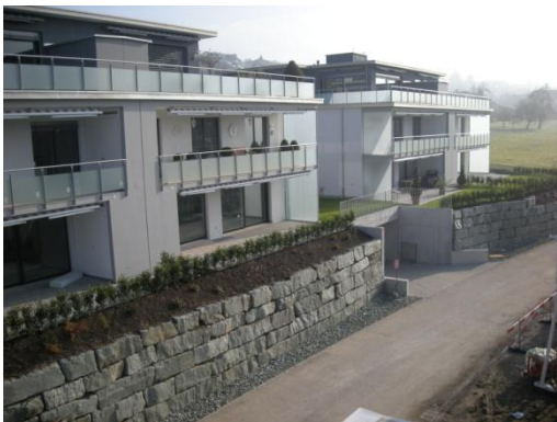
7 MFH Bündli Seengen Neuanlage Andeer-Quader Natursteinmauer mit Treppen / Spez. Andeer Natursteinverbundsteine / Terrassen Natursteinplatten / Bepflanzung / Rasenflächen
